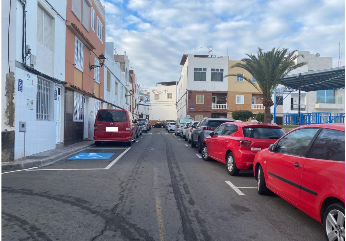
Fotografía nº 12 Avda. de Los Pescadores (vista hacia calle Fernando Arencibia)
